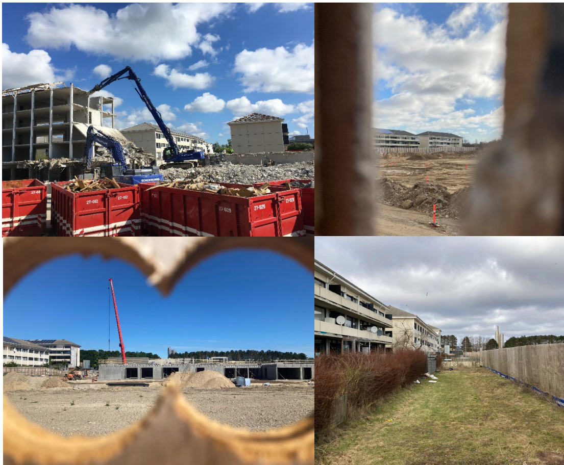
Figur 19: Fotos fra byggepladsen midt i Taastrupgaard, som den forvandles fra nedrivningsplads til byggeplads. Hegnet skaber nye barrierer, grænser og rum i kvarteret.
