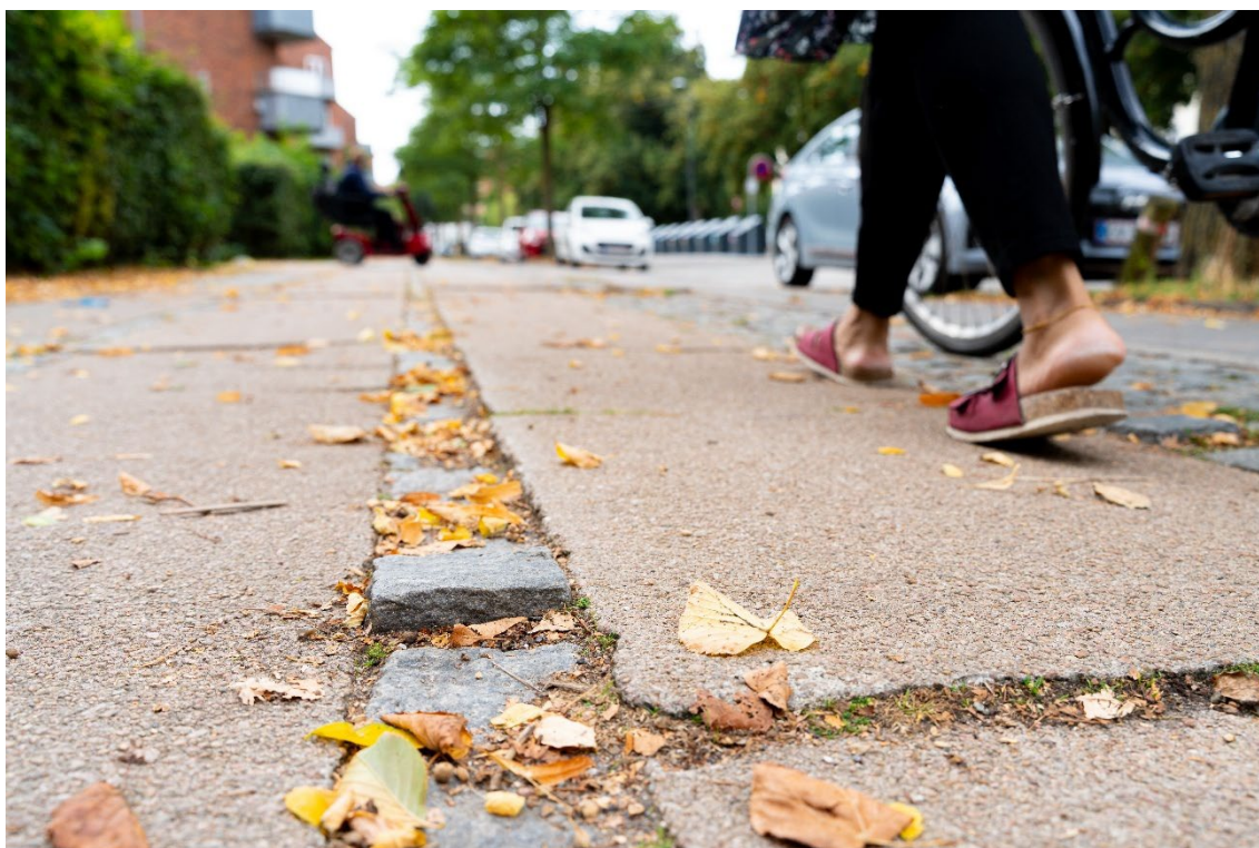
Foto: Fortovet umiddelbart uden for ældreboligområdet
